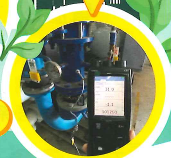
設備機房溫度檢測
